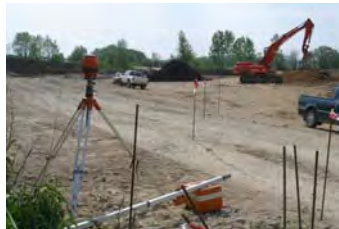
Durchführung der Erdarbeiten
