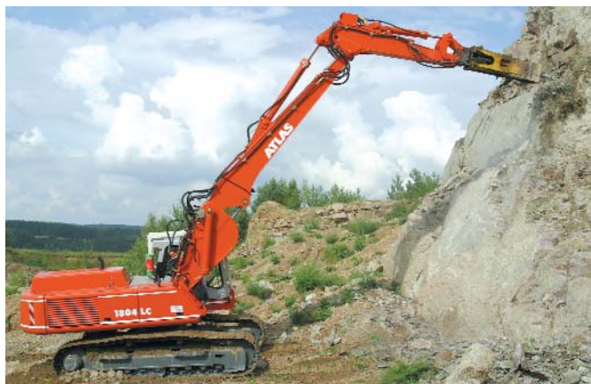
Die Arbeiten im Steinbruch Raning laufen auf Hochtouren.
