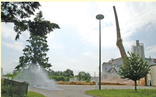
Seit 23. Juni fehlt auf dem Gelände der Südstärke GmbH in Sünching der Kamin: Er hat ausgedient und wurde fachmännisch per Sprengung zu Fall gebracht.
