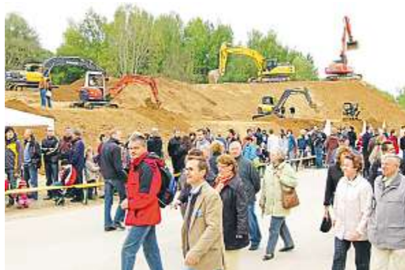
Zahlreiche Bagger dürfen am Tag der offenen Tür von Besuchern bedient werden.
